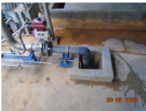
ภาพที่ 2-14 ถึงปรับปรุงสภาพความเป็นกรด-ด่าง (Neutralization Tank)
