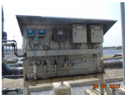
ภาพที่ 2-11 เครื่องตรวจวัดคุณภาพน้ำหล่อเย็นแบบ อัตโนมัติบริเวณบ่อพักน้ำหล่อเย็น
