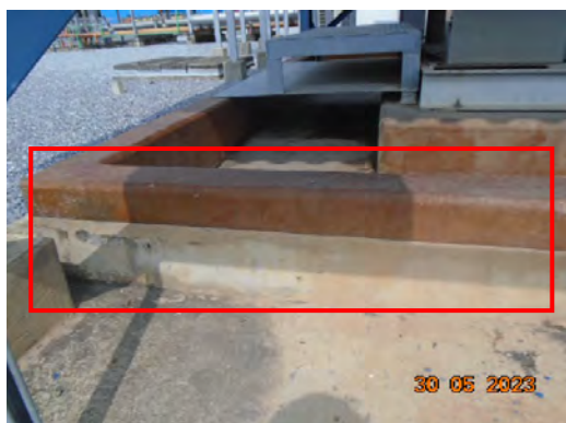
ภาพที่ 2-32 พื้นที่เก็บสารเคมีที่มีคันคอนกรีตรอบ ถึงเก็บสารเคมี
