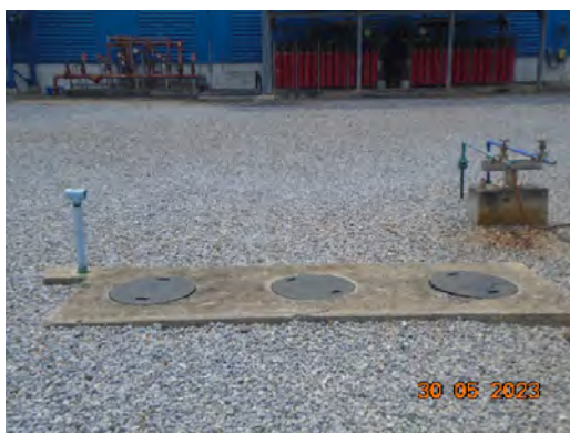
ภาพที่ 2-15 ถึงบำบัดน้ำเสียจากการอุปโภค-บริโภค
