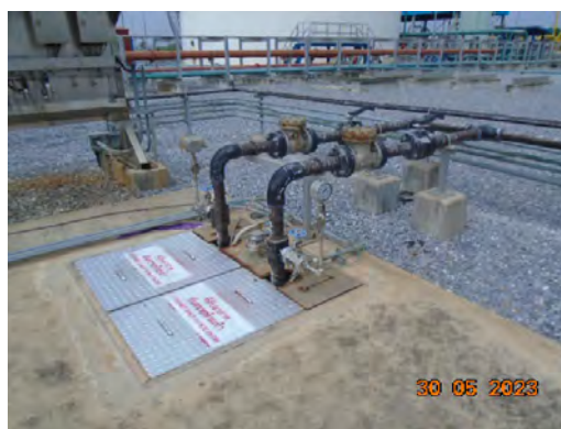
ภาพที่ 2-13 วาล์วควบคุมการเปิด-ปิด บริเวณบ่อตรวจสอบคุณภาพน้ำทิ้ง
