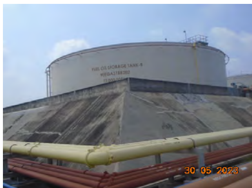
ภาพที่ 2-40 คันล้อมรอบบริเวณถังเก็บน้ำมัน
