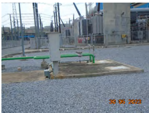
ภาพที่ 2-17 บ่อแยกน้ำมัน (Oil Separator)
