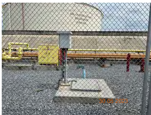
ภาพที่ 2-17 บ่อแยกน้ำมัน (Oil Separator)
