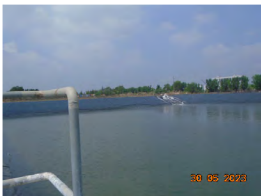
ภาพที่ 2-10 บ่อพักน้ำหล่อเย็น ขนาด 11,000 ลูกบาศก์เมตร
