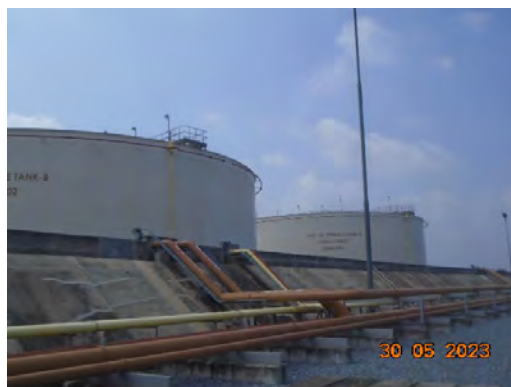
ภาพที่ 2-40 คันล้อมรอบบริเวณถังเก็บน้ำมัน
